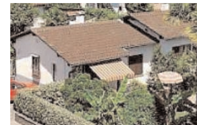
Satteldach mit Ziegeln
