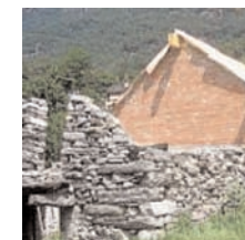
Altbau zum Renovieren
